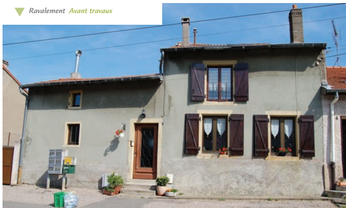
▼ Ravalement Avant travaux
