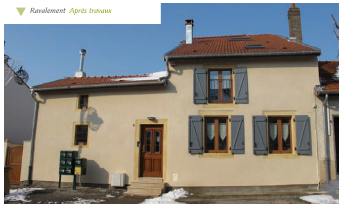
▼ Ravalement Après travaux
