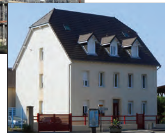
▲ Etat en 2015, après travaux
