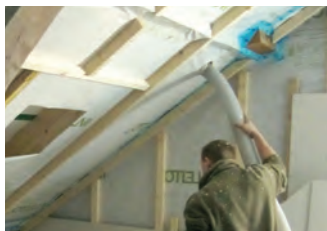
▲ Chantier d'isolation thermique de combles, avec laine de bois soufflée derrière les parements de plaques de plâtre.
