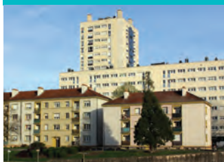
▲ Metz. Deux types d'immeubles urbains d'après 1948, situés aux abords de la cathédrale, rénovés par isolation
