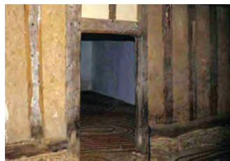
▲ Les dispositifs de chauffage par le sol permettent de façon concomitante l'isolation thermique du sol (trop souvent oubliée) et l'assèchement des parties humides, éléments clés du confort intérieur.
