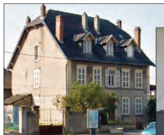
▲ Etat en 2013, avant travaux de rénovation
