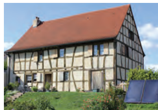
▲ Maison identitaire et remarquable, du début du XVIII ème siècle, scrupuleusement restaurée en intérieur et extérieur. Isolation thermique intérieure en laine de chanvre, chauffage par aérothermie, n'impactent pas l'aspect du bâtiment. Les capteurs solaires, généralement posés sur le toit, prennent ici place sur le sol du jardin.
