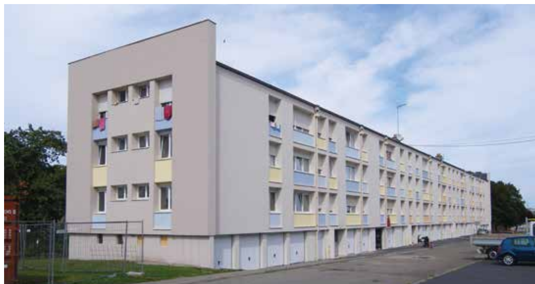
▲ Immeuble Moselis à Sarrebourg, réalisation Jean-Louis Mohoric - La pose d'une ITE a été mise à profit pour recomposer les façades
