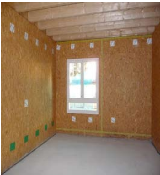
Photo WMG Architecte
