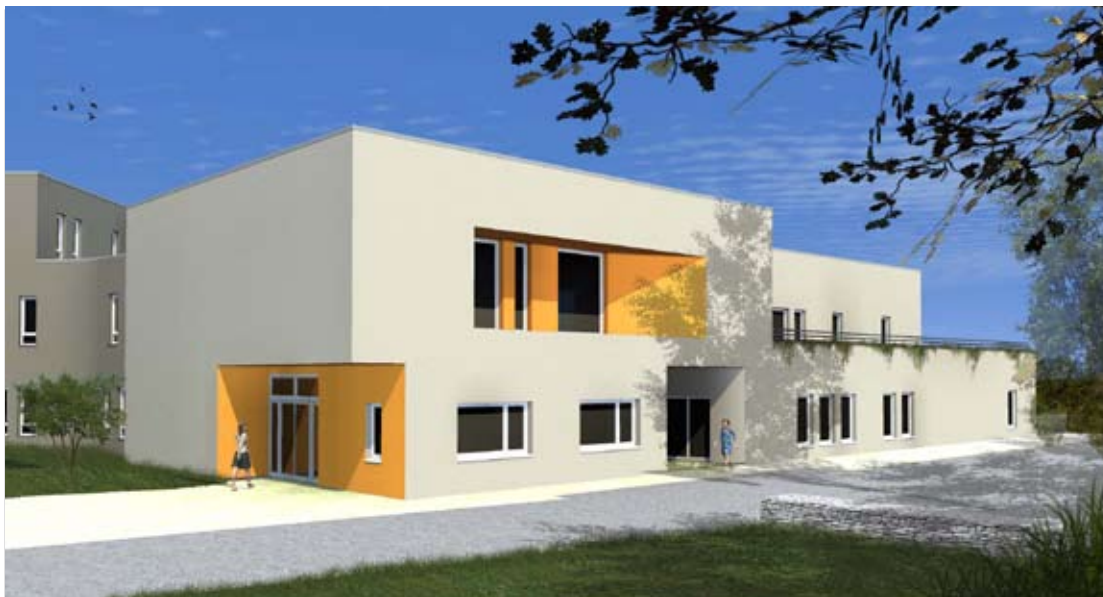
Photo WMG Architecte
