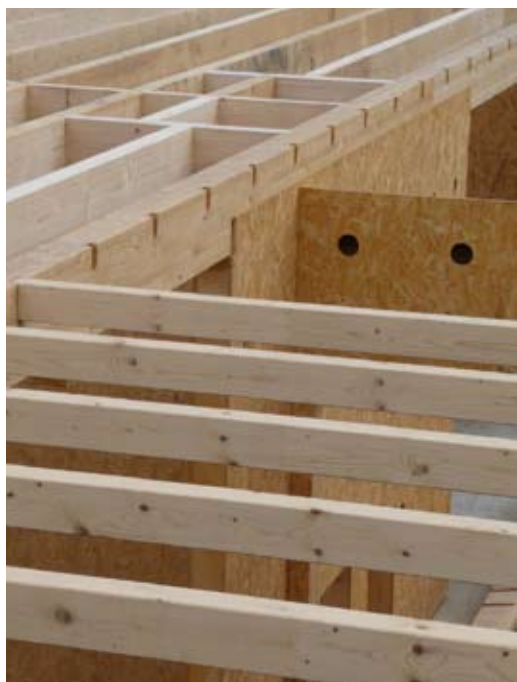
Photo WMG Architecte
