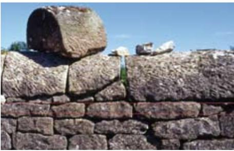
**Pierres sèches** : (*n.f.*) maçonnerie de pierres appareillées, sans utilisation de mortier. C'est l'empilement et l'assemblage correct des pierres qui assure la cohésion de l'ensemble. Cette technique est essentiellement utilisée pour les murs de clôture et de soutènement.
