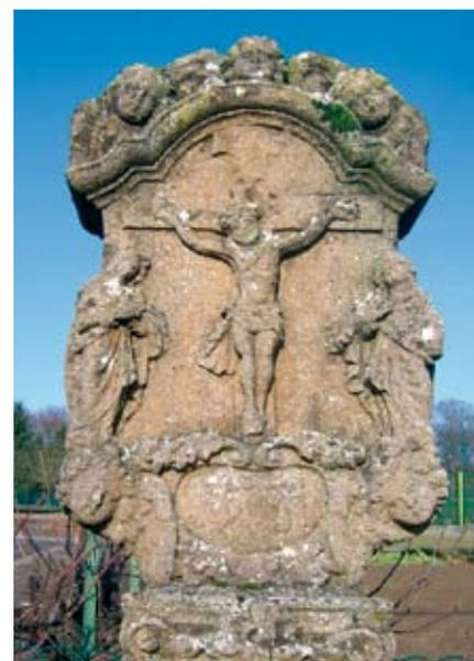
Les mousses épaisses doivent être éliminées sur tous les ouvrages, notamment les toitures, ou elles sont source d'infiltration d'eau, sur les sols et les escaliers ou elles peuvent provoquer des accidents par glissade et sur les couvrements des murs.
