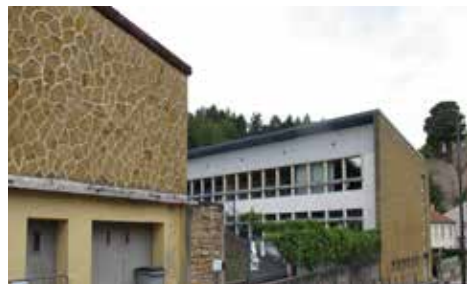
▲ façade en pierres
