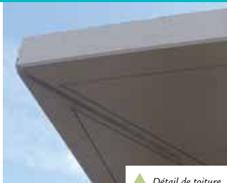
▲ Détail de toiture
