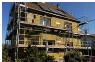
▲ Chantier d'ITE en laine de roche
