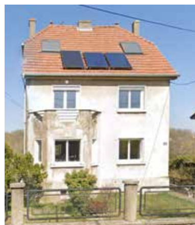
▲ façade 1930 avec murs en moellons
