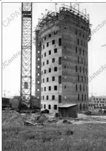
Forbach - Wiesberg coffrage grim pant(2) 1960/65, E.Aillaud, architecte.
