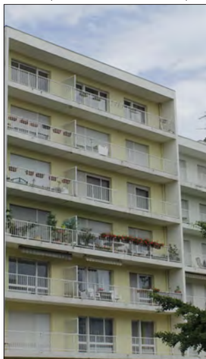
Longeville-les-Metz - balcons filants à garde-corps acier.
