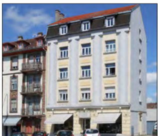
Sarrebourg - immeuble 1926 avec façade entièrement en mortier.
