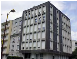
Longeville-les-Metz - façade avec panneaux préfabriqués en béton et carreaux de céramique.
