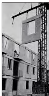
Préfabrication lourde - procédé Camus.
