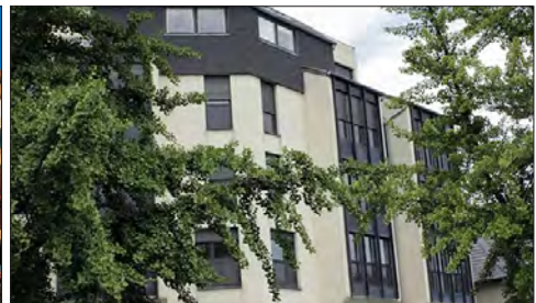
Longeville-les-Metz - murs rideaux totalement vitrés sur certaines portions de façade, années
